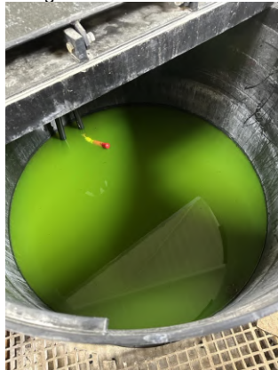
Figure 5 : Cuve Eaux usées
